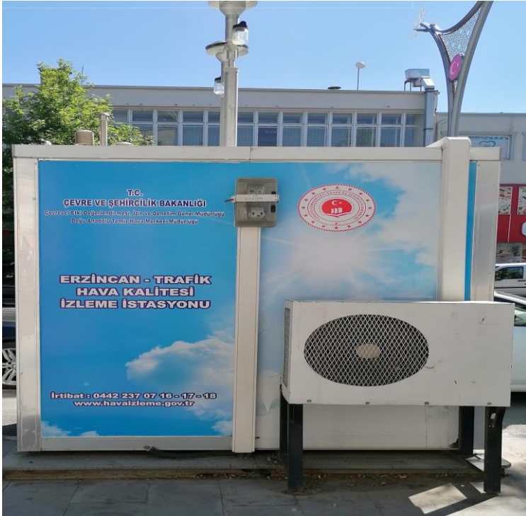
Resim-2: Erzincan ili Trafik Kaynaklı Hava Kalitesi İzleme İstasyonu
